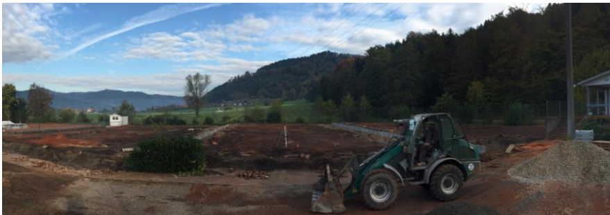
Platzsanierung von Oktober 2017 bis April 2018
